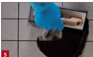
5 Fugázás a vezetőképes BOTAMENT® SF 100 habarccsal
