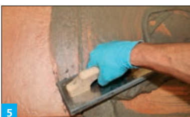
5 Csempék fugázása CF 200 speciális fugázóhabarccsal
