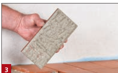
3 Járólapok fektetése kombinált módszerrel
