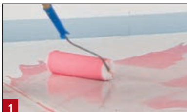
1 Fal- és padlófelületek alapozása BOTAMENT® D 11-gyel
