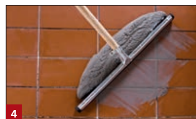
4 Multifuge Base iszapolása gumiszerszámmal
