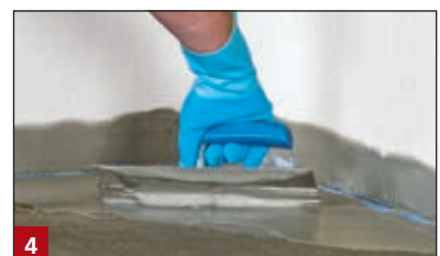
4 A BOTAMENT® MD 1 Speed szigetelés második rétegének felhordása
