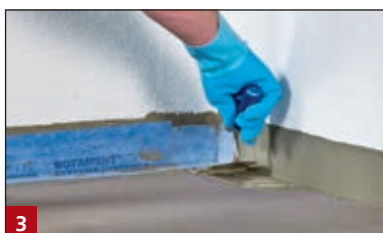
3 BOTAMENT® SB 78 sarokerősítő szalag és tartozék behelyezése a friss szigetelő-rétegbe
