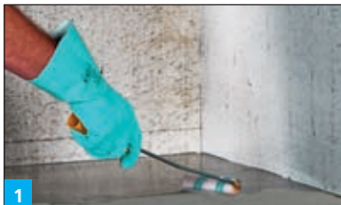
1 Az aljzat alapozása BOTAMENT® E 120 epoxigyanta alapozóval
