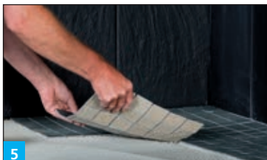
5 A mozaikburkolat rögzítése BOTAMENT® EF 500 EK 500 epoxigyanta fugázó- és ragasztóhabarccsal vagy MULTISTONE-nal
