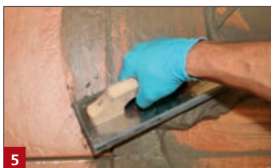
5 CF 200 bedolgozása fugasimítóval
