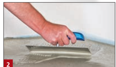
2 A BOTAMENT® MD 1 Speed szigetelés első rétegének felhordása
