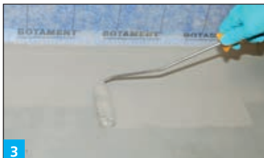
3 A BOTAMENT® RA 170 reaktív gyanta szigetelés 2K második rétegének felhordása
