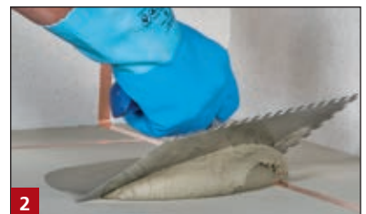
2 BOTAMENT® TK 150 felkenése megfelelő méretű fogazott szerszámmal
