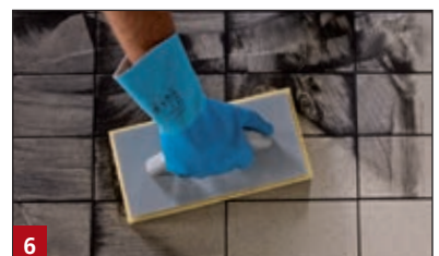
6 BOTAMENT® SF 100 vezetőképes fugázóhabarcs átmosása. Ügyelni kell arra, hogy a fuga szintben legyen a felülettel.
