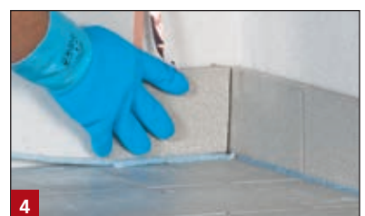
4 Lábazat kialakítása BOTAMENT® TK 150-nel
