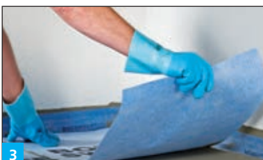
3 AE szigetelő és feszültségmentesítő lemez elhelyezése a friss BOTAMENT® M 21 emelt szintű ragasztó, vagy M 10 Speed ragasztóágyon
