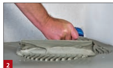
2 BOTAMENT® M 29 HP prémium flex padlóragasztó felkenése
