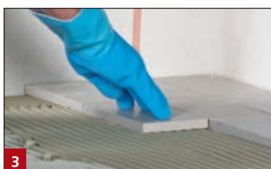
3 Levezetőképes csempék behelyezése BOTAMENT® TK 150 ragasztóágyba
