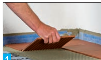
4 Csempék rögzítése M 21 emelt szintű ragasztó, vagy M 10 Speed flex gyorsragasztóval
