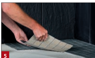
5 Burkolat rögzítése M 21 ragasztóval, majd terheléstől függően fugázás Multifuge Diamonddal
