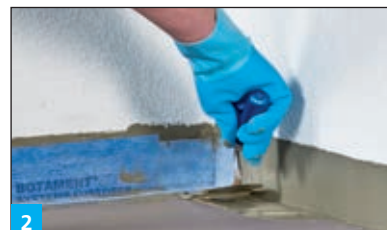
2 BOTAMENT® SB 78 erősítő szalag + belső sarokidom ragasztása M 21 emelt szintű ragasztóval vagy M 10 Speed flex gyorsragasztóval
