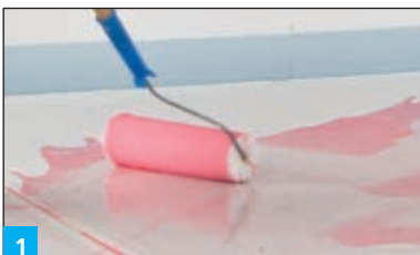
1 Esztrich alapozása BOTAMENT® D 11 mélyalapozóval
