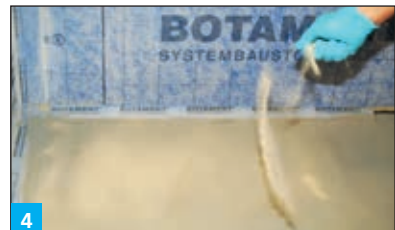
4 A második szigetelőréteg megszórása 0,5-1,2 mm szemnagyságú kvarchomokkal a csempeburkolás megkezdése előtt
